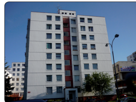
BYT 3+1 TACHOV, Trocnovská ulice
